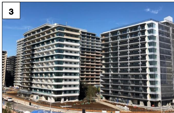
3 5-6 街区の整備状況(外装、外構、植栽)
